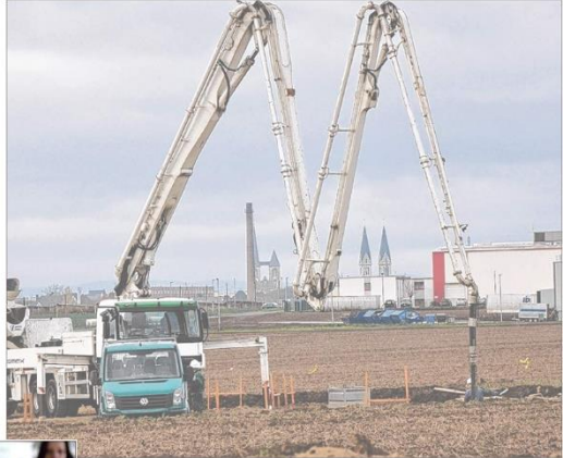
In Halberstadt entsteht auf einem 4200 Quadratmeter umfassenden Gelände im Industriegebiet ein neues Umspannwerk. Die Avacon AG investiert dafür 1,3 Millionen Euro.
