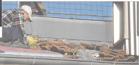
Die Dachsanierung des Gleimhausanbaus hat begonnen. Dachdecker nehmen die Ziegel hoch, um darunter eine wasserdichte Schicht einzubauen. Seit Jahren leckt das Dach. Dadurch waren die wertvollen Bestände des Museums und des ebenfalls dort untergebrachten Historischen Stadtarchivs gefährdet.
