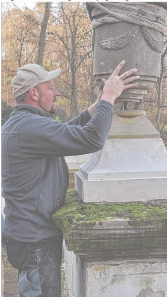
Steinmetzmeister Fränk Zimmer setzt die erste von zwei Vasen auf den neugefertigten Sandsteinsockel am Eingang zum Spiegelmausoleum. Das Denkmal war im Frühjahr während eines Unwetters stark beschädigt worden.
