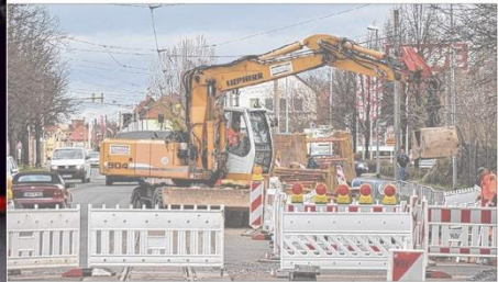
Seit Monaten im Bereich der Klus- und der Hans-Neupert-Straße zu. Halberstadtwerke und Netzelectric verlegen dort Ver- und Entsorgungsleitungen.
