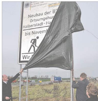
Thomas Webel (CDU, links), Minister für Landesentwicklung und Verkehr, und Enak Ferlemann, Parlamentarischer Staatssekretär im Bundesministerium für Verkehr und digitale Infrastruktur, geben den offiziellen Start für den Bau der 7,3 Kilometer langen und 32,9 Millionen Euro teuren Ortsumgehung Halberstadt-Harsleben.
