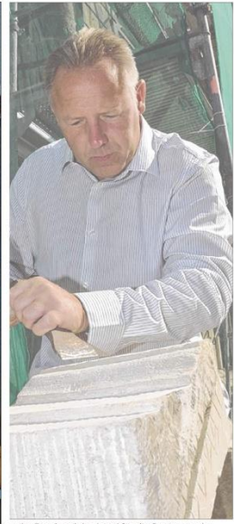
n der Bund und das Land für die Sanierung der tädtschen Museums zur Verfügung gestellt. Steinat am über 230 Jahre alten Gebäude alle Hände
