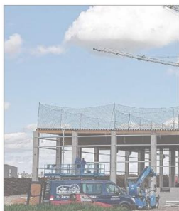
An der Luther-Augustin-Straße in Halberstadt entsteht eine neue Fabrik. Investiert werden etwa 17 Millionen Euro.
