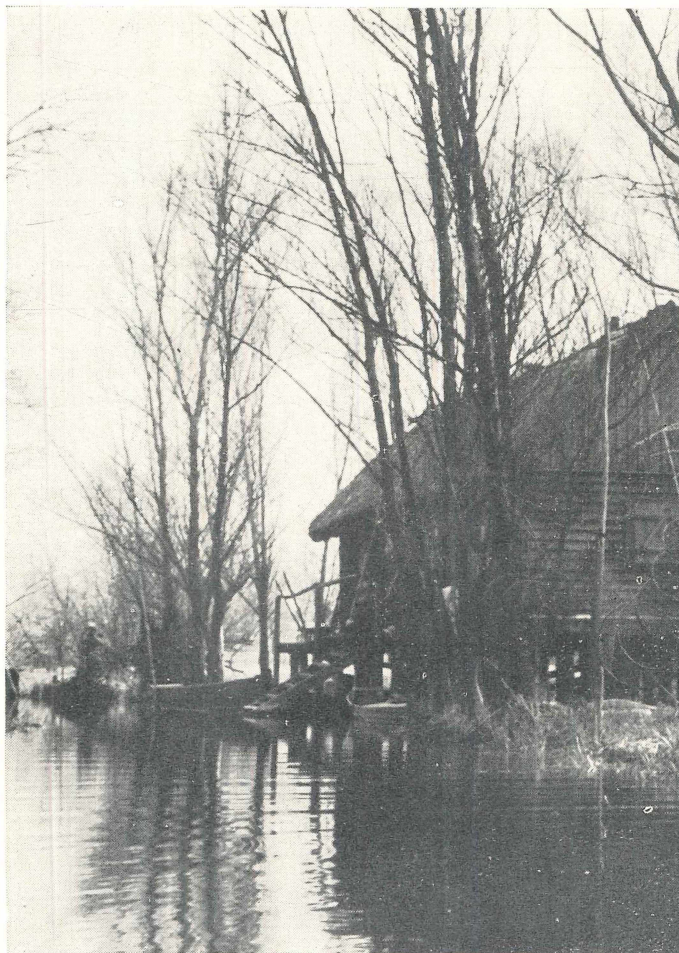
Abb. 1: Ehemalige Fischerhütte am Abflußgraben des Sees –
