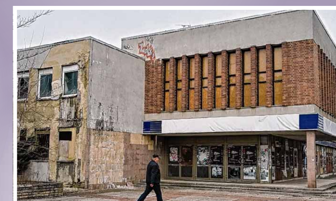
1. Februar: Oberbürgermeister Andreas Henke (Linke) informierte, dass Bewegung in den Abriss des Klubhauses kommen soll. Danach will ein einheimischer Investor nach dem Abriss dort ein neues Gebäude errichten. Über die künftige Nutzung sei noch nichts bekannt.
