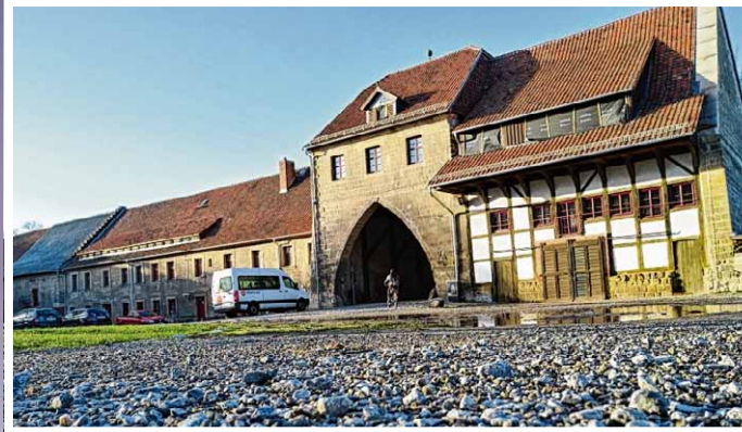
7. Januar: Das Land Sachsen-Anhalt und der Bund unterstützen Halberstadt finanziell bei Sanierungsvorhaben. Insgesamt 1,66 Millionen Euro stehen für mehrere Bauprojekte in den kommenden fünf Jahren zur Verfügung. Unter anderem für das Burchardikloster.
