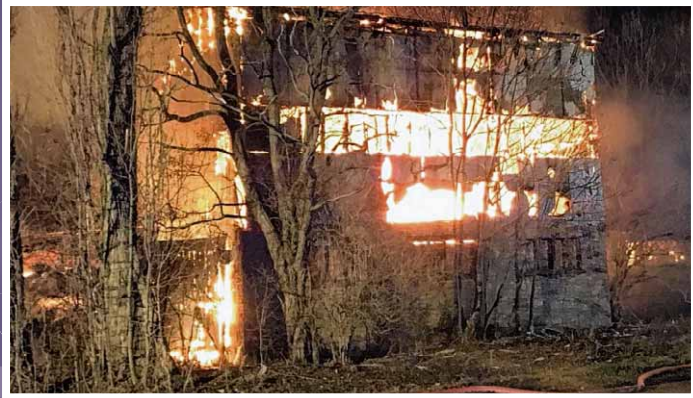
2. Januar: In der Nacht zum 1. Januar 2019 gegen 1.15 Uhr brennt in Emersleben die alte Hopfendarre. Die eingesetzten Wehren konnten nicht verhindern, dass das mit Stroh gefüllte Gebäude komplett niederbrennt. Foto: Chris Buchold
