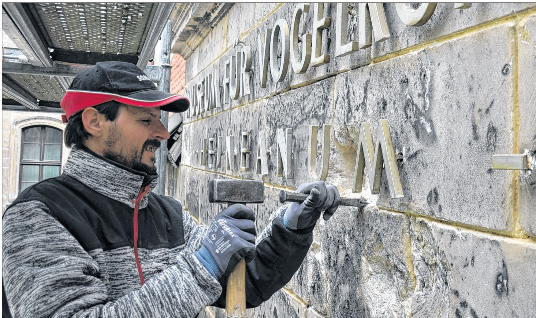
Steinmetz Björn Schröder saniert die Fassade des Heineanums Halberstadt.
